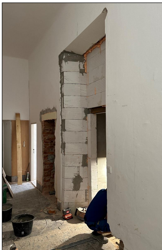
Budování výtahu – stav v druhé polovině srpna...
