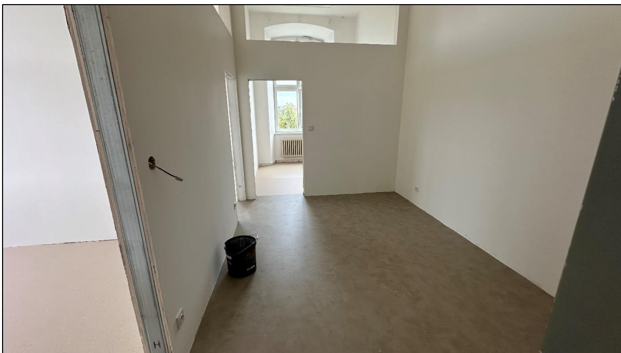
Výstavba nových místností v prostoru někdejší sborovny – stav v druhé polovině srpna
