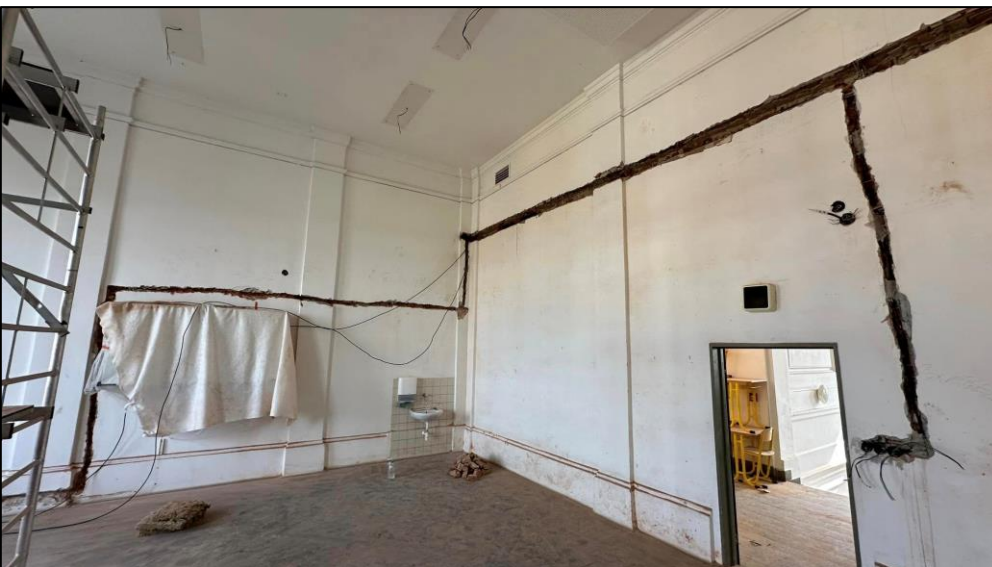
Stav prací k 27. červnu – zasekávání elektroinstalace v prvním a druhém patře
